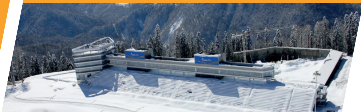
Горно–туристический центр «Лаура»: эксплуатация котельной
