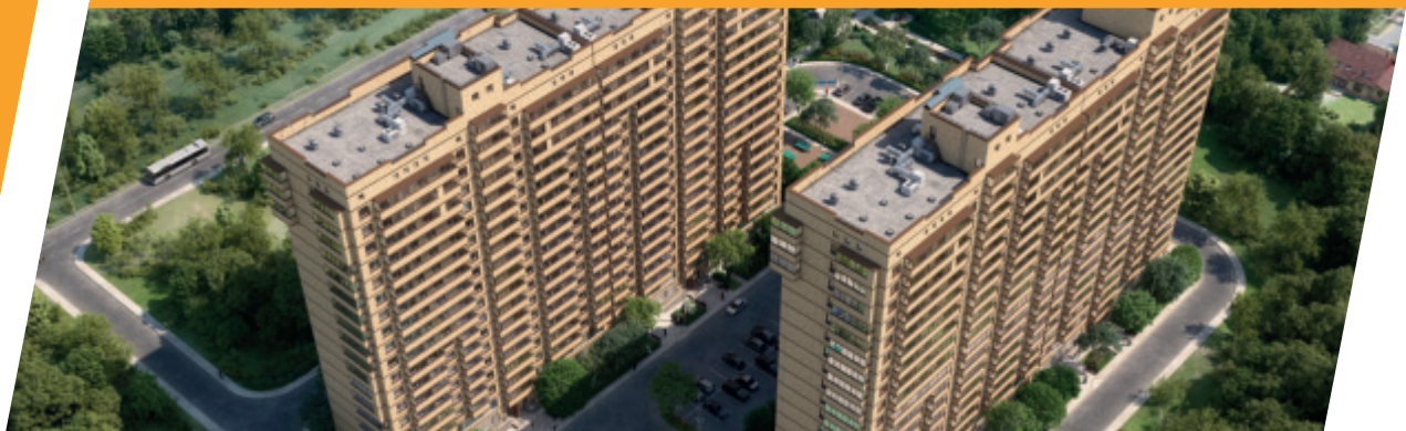
Жилищный комплекс «Гарант»: строительство новой каркасной котельной
