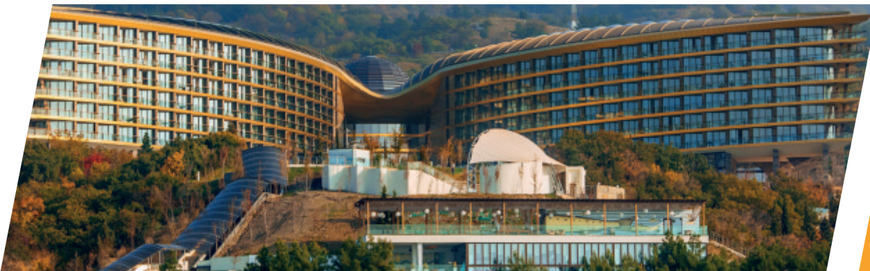
Mriya Resort & Spa: эксплуатация котельной
