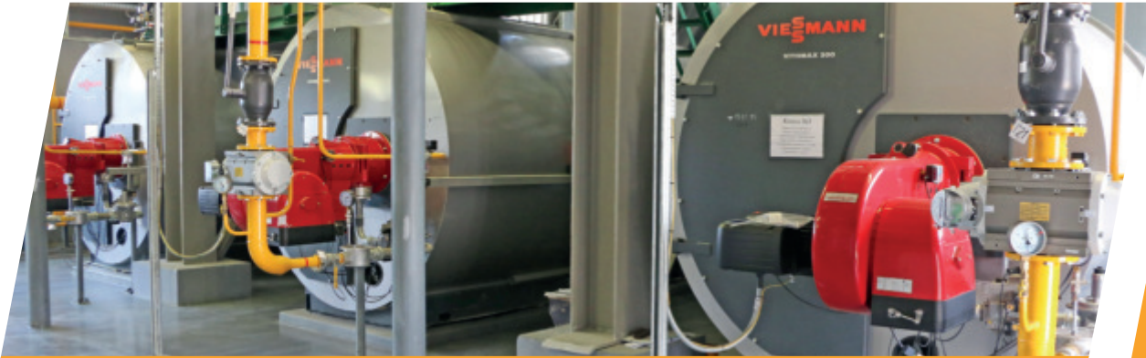
ГТК ПАО «ГАЗПРОМ»: наладка оборудования котельной на двух видах топлива
