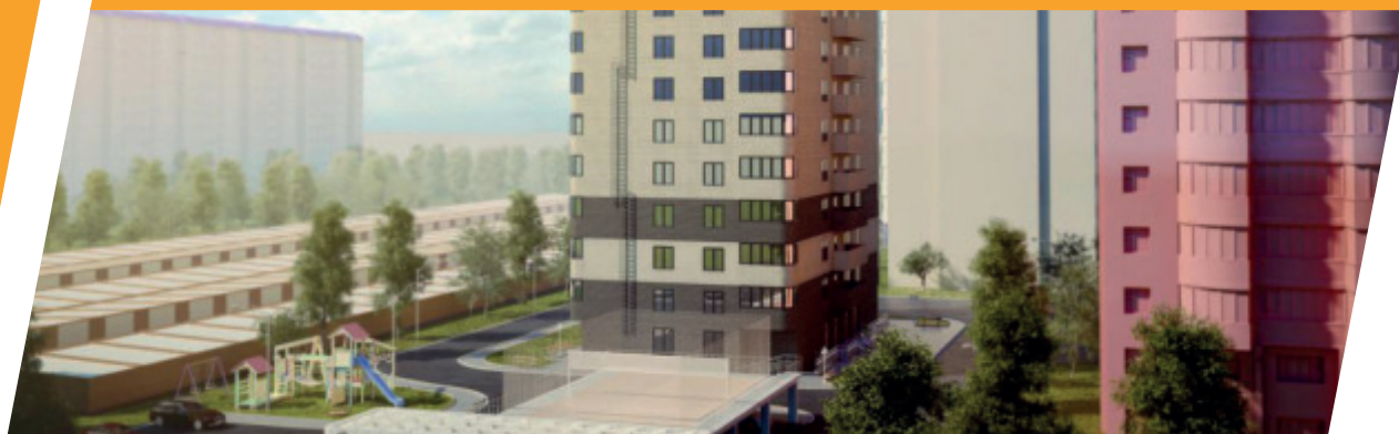
Жилищный комплекс «Новая ЭНКА»: строительство крышной котельной
