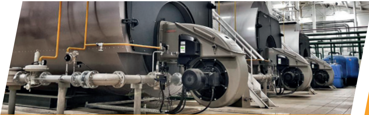
АПК «Астраханский»: строительство производственной котельной под ключ, 85 т. пара/час
