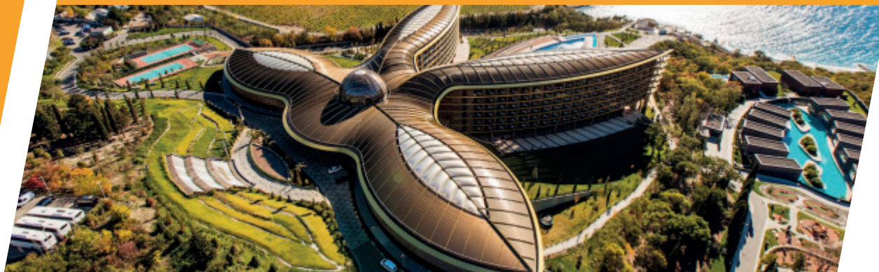
Mriya Resort & Spa: эксплуатация котельной
