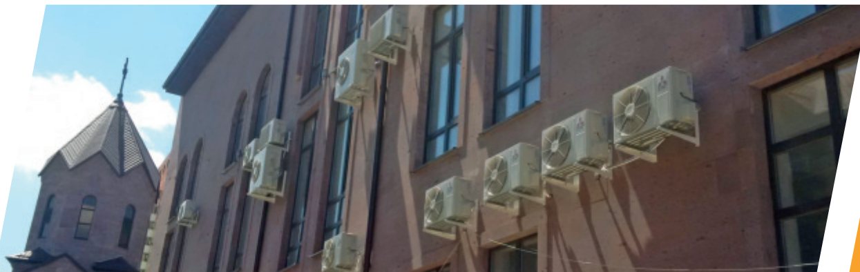
Монтаж систем отопления, вентиляции, кондиционирования, водопровода, канализации
